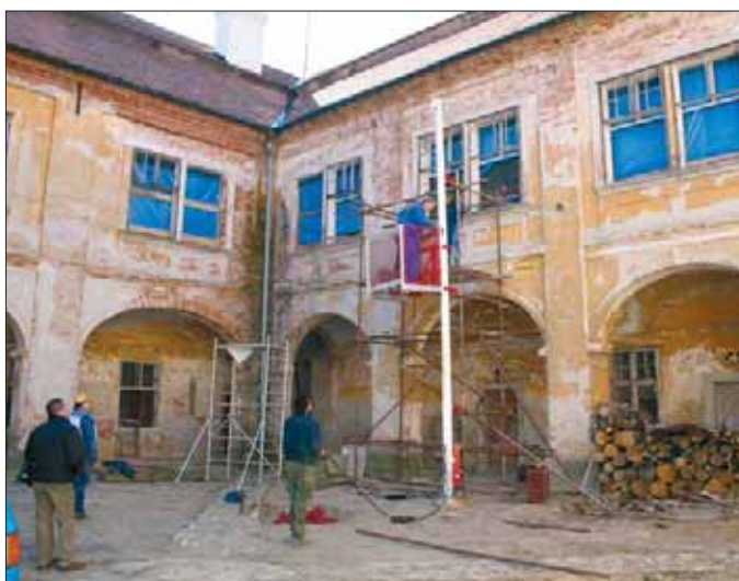
Opravy jsou v plném proudu, snímek zachycuje nádvoří zámku. Foto: Iva Horká
