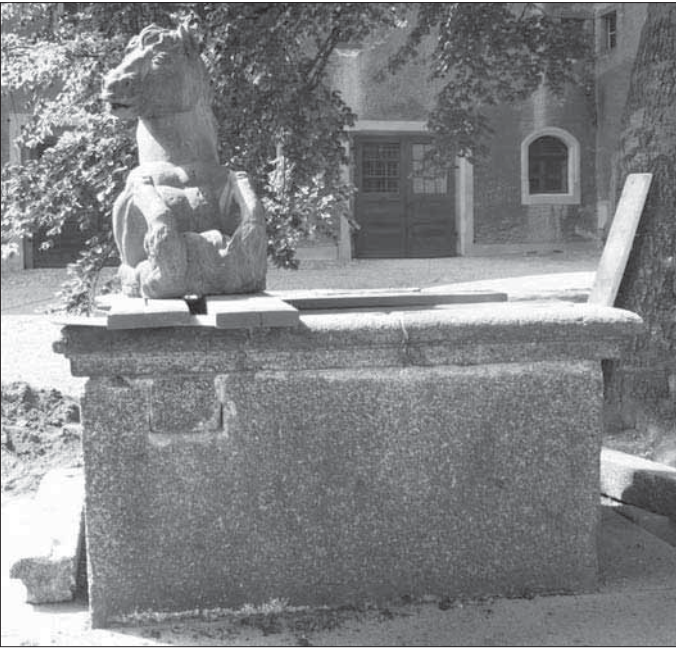
Zámecká kašna v době oprav.
