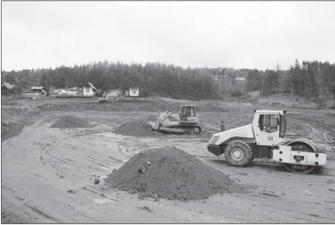
Na Jihlavské ulici v místě bývalé skládky začali se stavbou fotovoltaické elektrárny. Foto: Martina Strnadová
