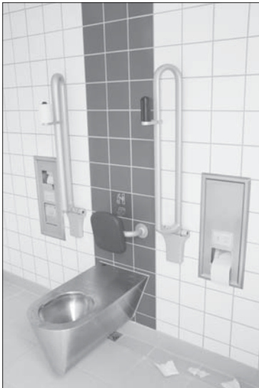
Interiér dámských toalet, které slouží také pro lidi na vozíčku. Těm, kteří by si třeba nevěděli rady, jak funguje splachovací systém, napovídá náš snímek – je třeba se rukou dotknout nejtavší kachličky s obrázkem.
