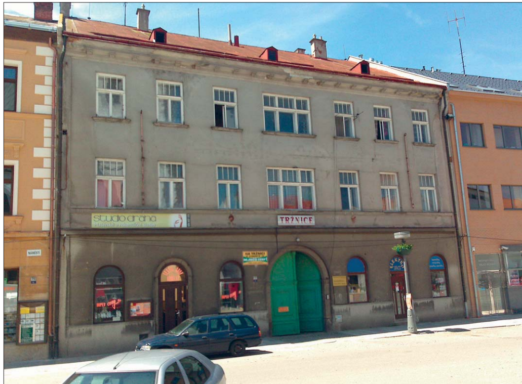
Budova Svitu byla před rekonstrukcí v dezolátním stavu. Chloubou zrovna nebyla.
