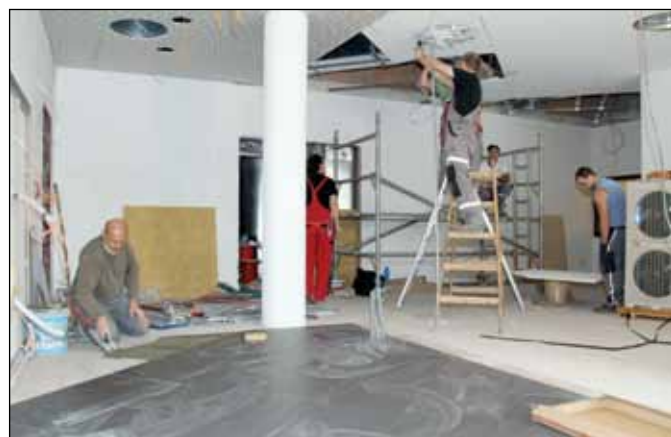
Snímek zachycuje práce na podlahách. Foto: Martina Strnadová
