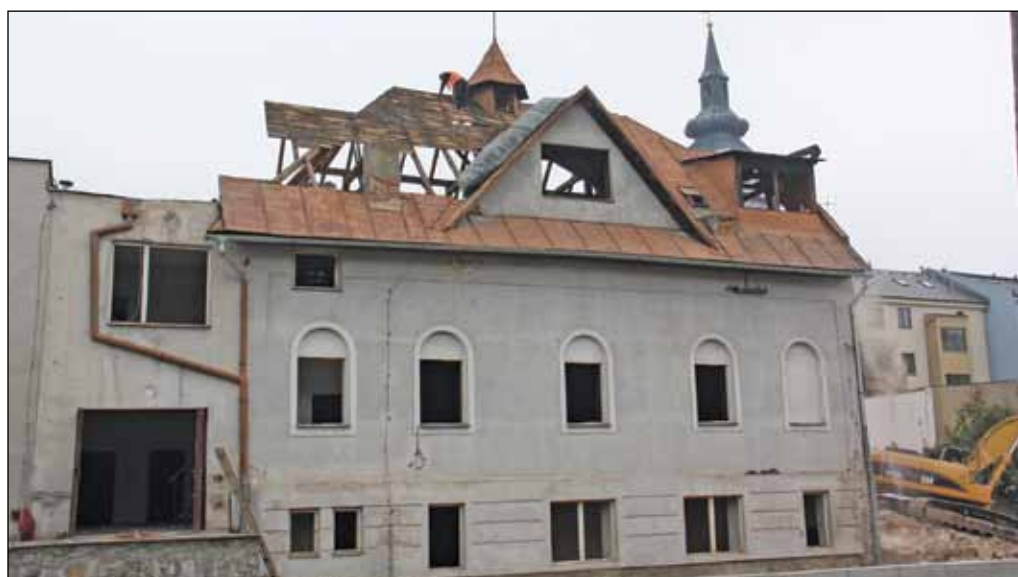
Pohled zezadu od řeky na budovu bývalé sokolovny v době, kdy začala její demolice. Foto: Martina Strnadová
