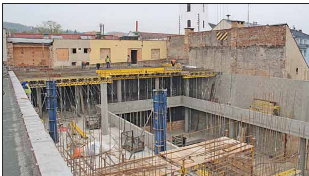
Fáze stavby víceúčelového sálu v dubnu 2014. Foto: Martina Strnadová. Více foto najdete také na našem webu www.velkomeziricko.cz .
