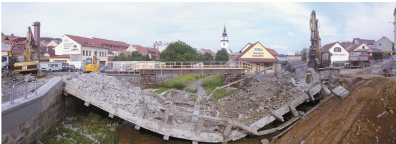
DEMOLICE starého mostu začala 11. června
