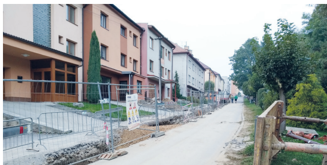
Stavba nové kanalizace v ulici Záviškově
