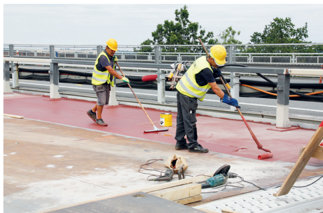
Aktuálně na mostě končí pokládka hydroizolace a aplikace protikorozičního nátěru. Následuje umístění přechodových desek.
