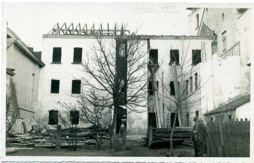
Bourání školy (pohled od řeky), foto: Archiv
