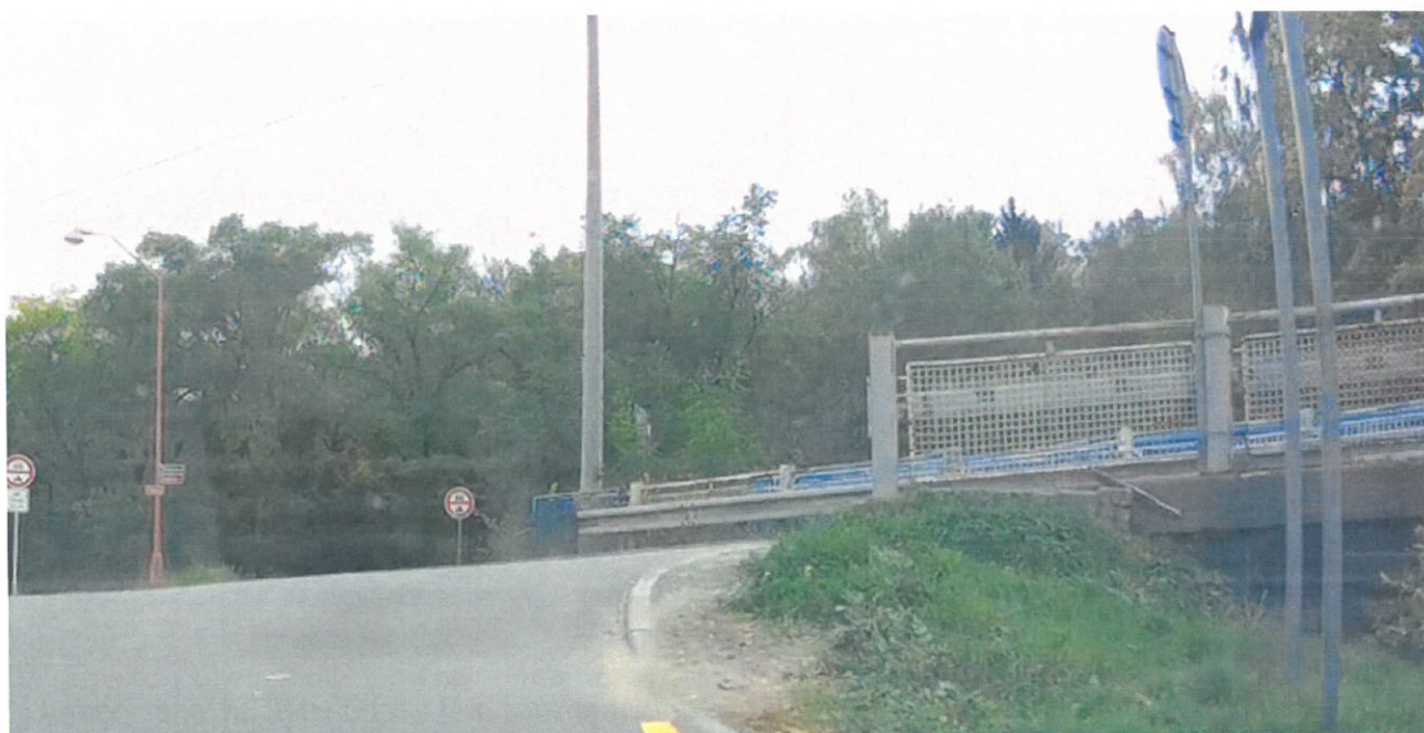
Obrázek 27 - Nevyhovující rozhledy i podélný sklon na vjezdu z ulice Družstevní na ulici Třebíčská
