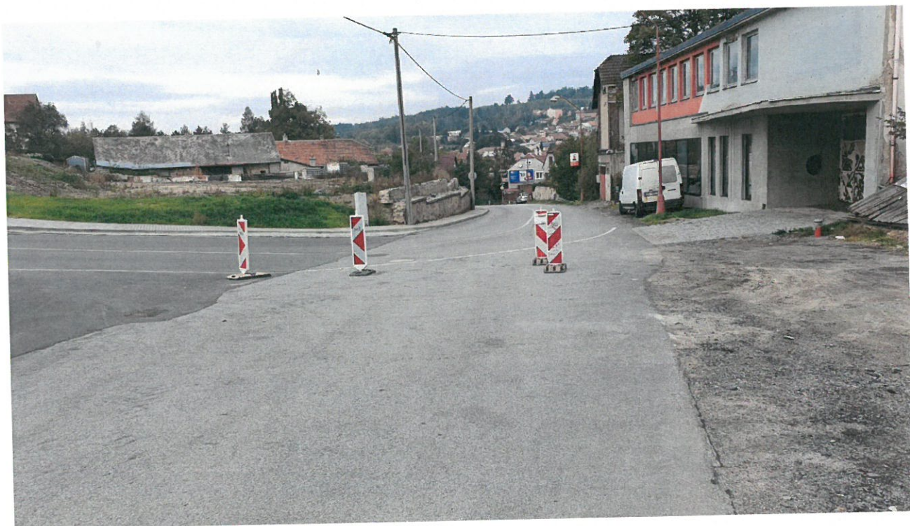
Obrázek 5 - Začátek přeložky místní komunikace ulice Třebíčská, pohled směr centrum
