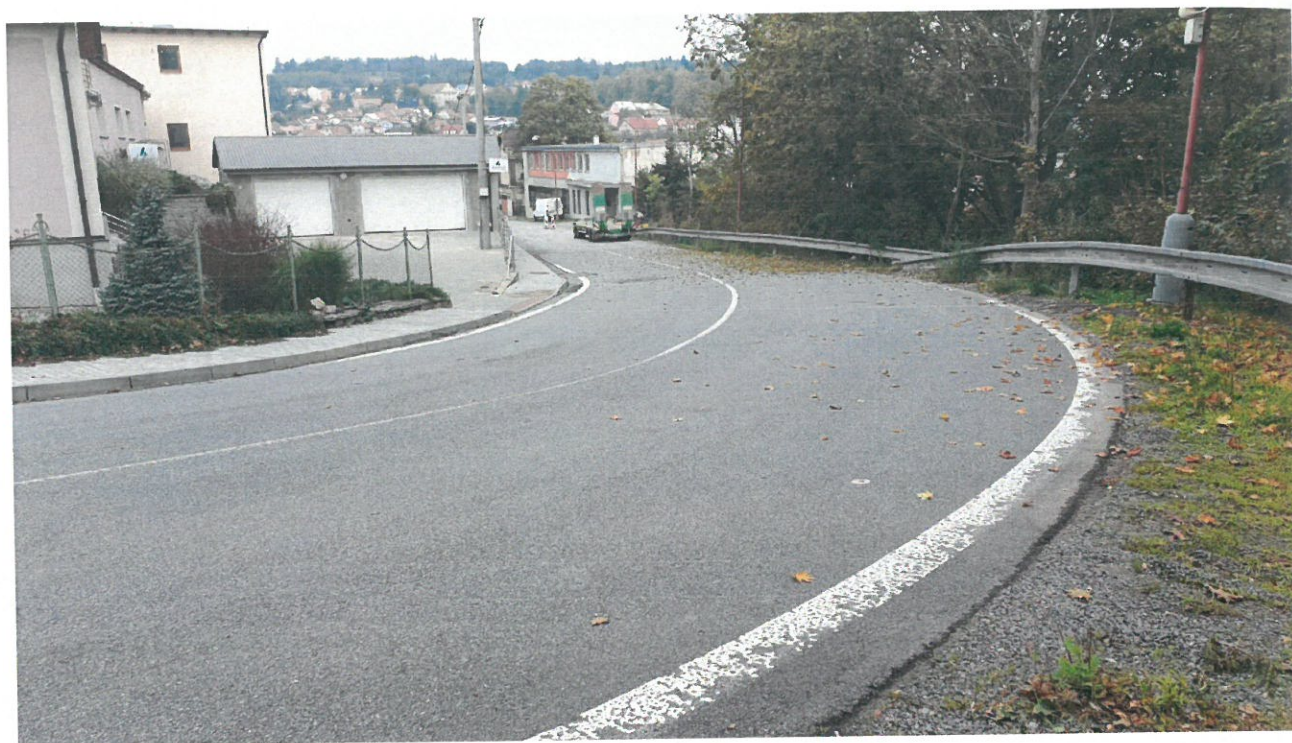
Obrázek 12 - Původní vedení ulice Třebíčská, dnes vjezd omezen dopravním značením, pohled směr centrum
