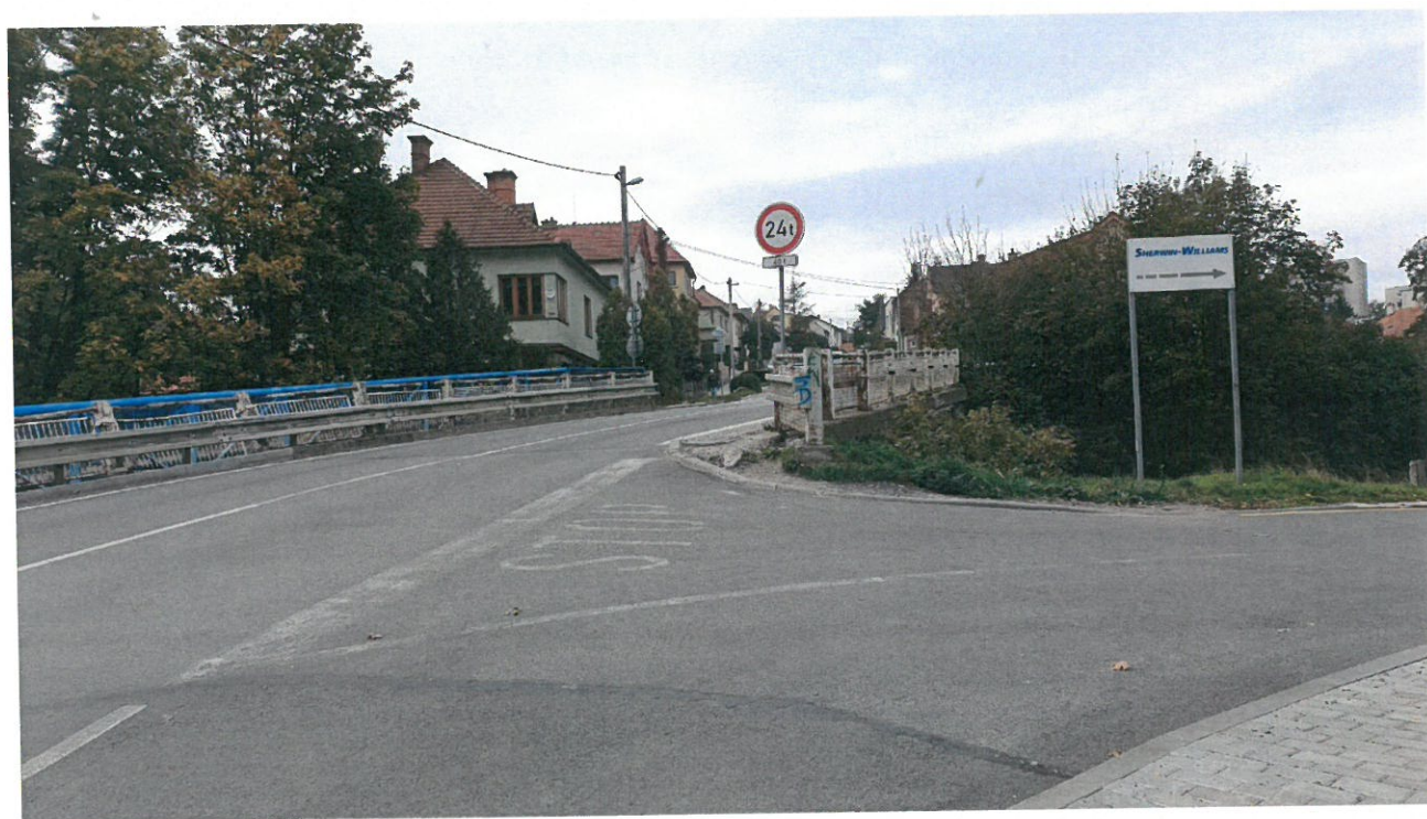
Obrázek 9 - Křižovatka přeložky místní komunikace ulice Třebíčská s ulicí Družstevní, nevyhovující rozhledové poměry vpravo
