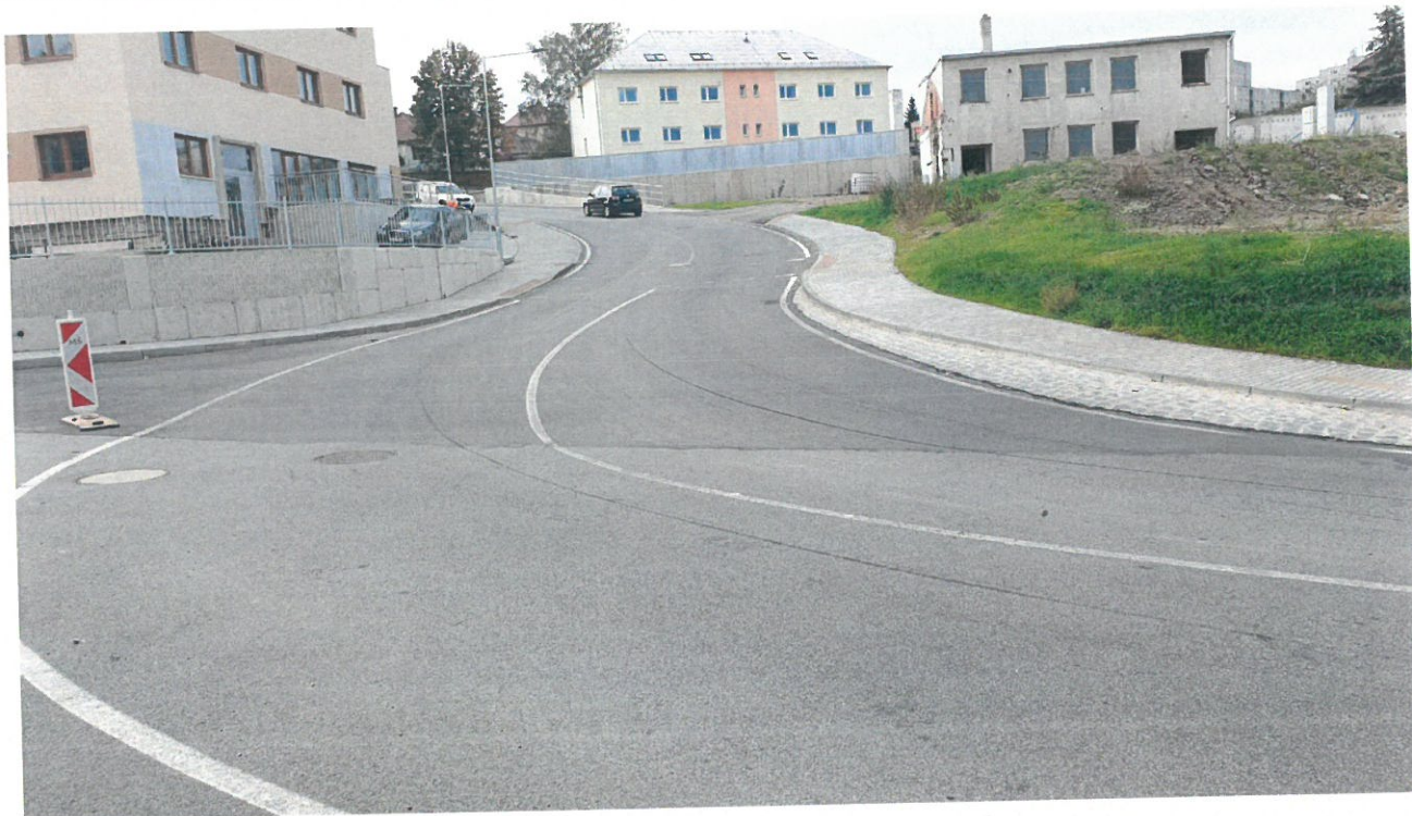
Obrázek 4 - Začátek přeložky místní komunikace ulice Třebíčská
