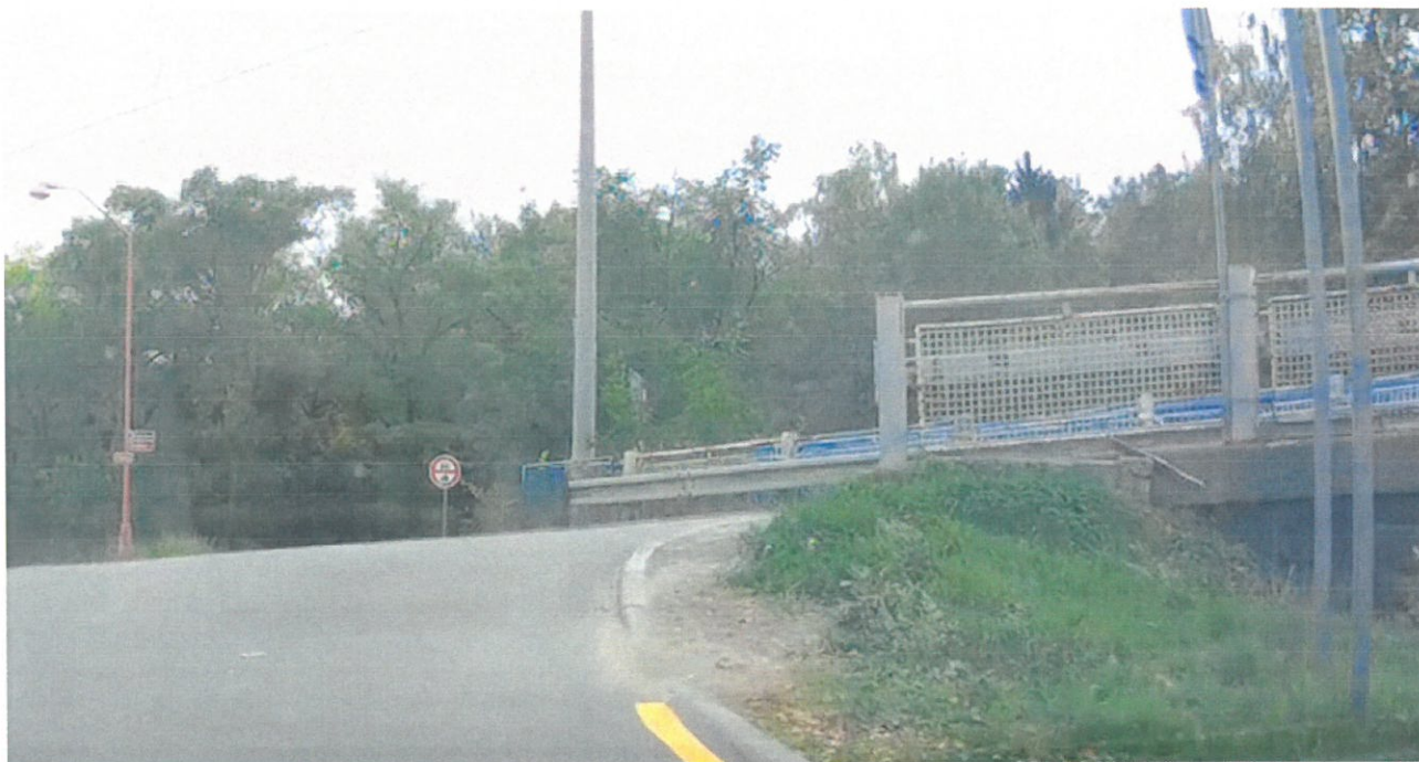
Obrázek 10 - Křižovatka přeložky místní komunikace ulice Třebíčská s ulicí Družstevní, nevyhovující rozhledové poměry vpravo
