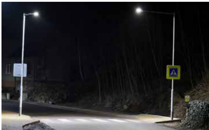
Stavba přechodu a chodníku ve Vrchovecké ulici je u konce.
