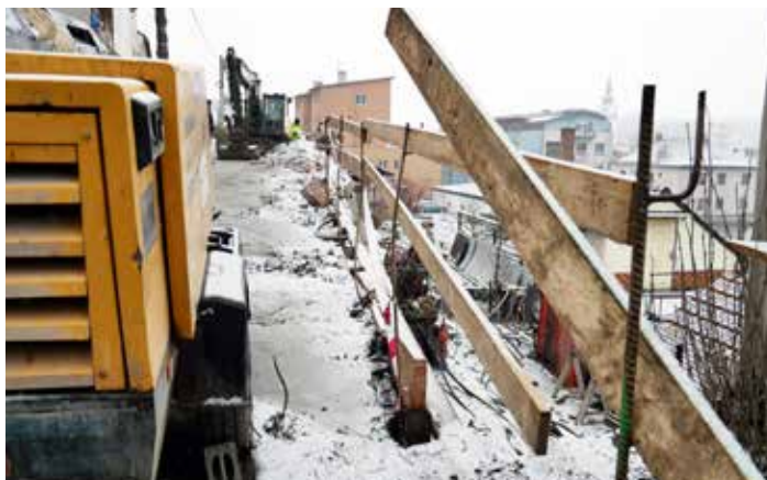
Do konce roku město opravuje opěrnou zeď na Bezděkově.
