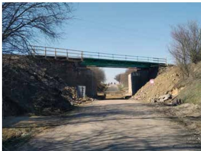
Od 28. března projíždí řidiči mezi Dobrou Vodou a Křižanovem kyvadlově. Důvodem je rekonstrukce železniční tratě i podjezdu.
