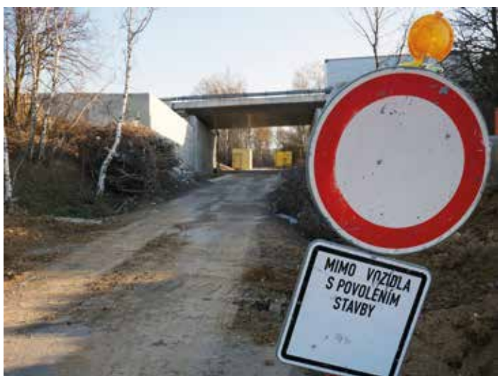
Podjezd k samotě Loupežník, který se rekonstruuje v rámci modernizace dálnice D1, řidiči poprvé projedou 1. července.
