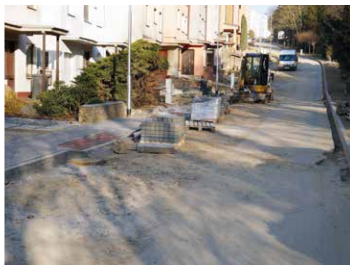
V ulici Závěškově je již nový vodovod a kanalizace a v současnosti se pokládá dlažba.
