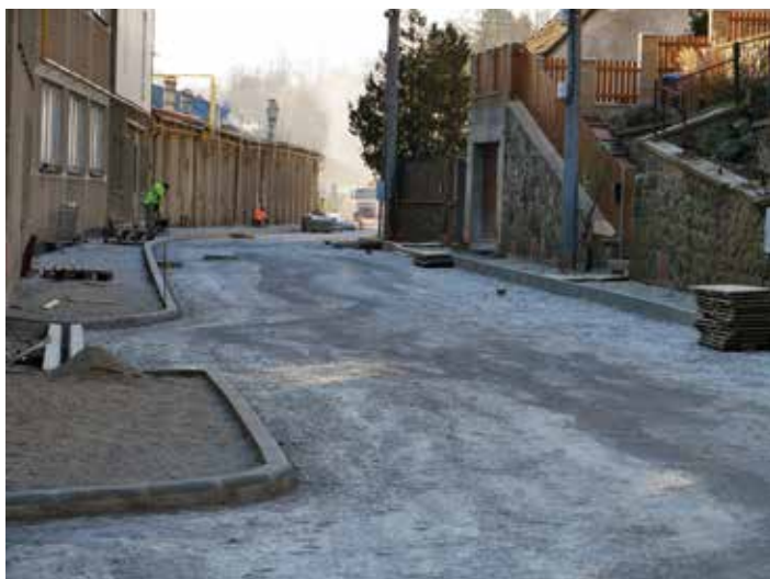
Místní komunikace Pod Strání prochází kompletní rekonstrukcí, kterou zhotovitel do léta dokončí.
