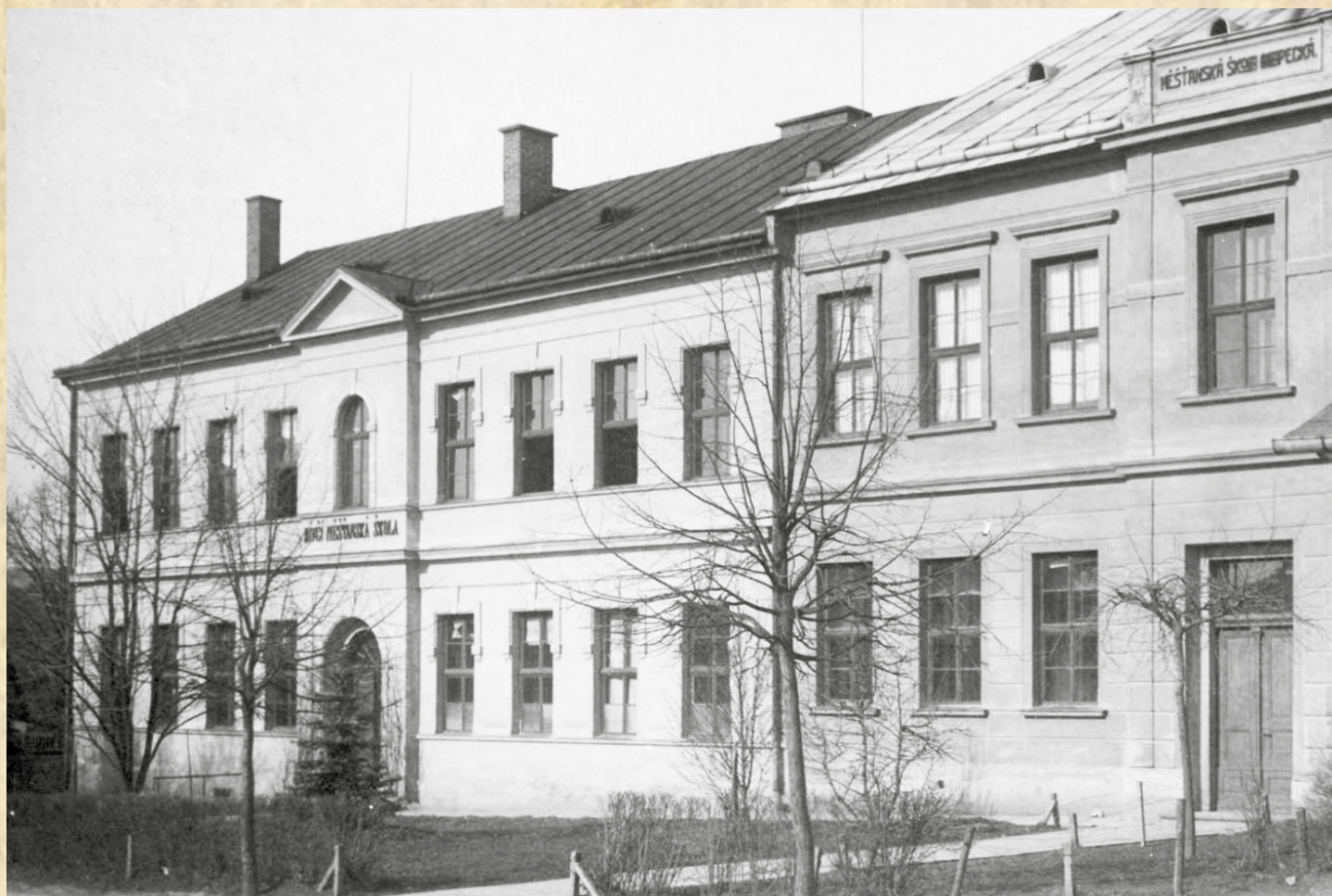
Škola v ulici Sokolovská
