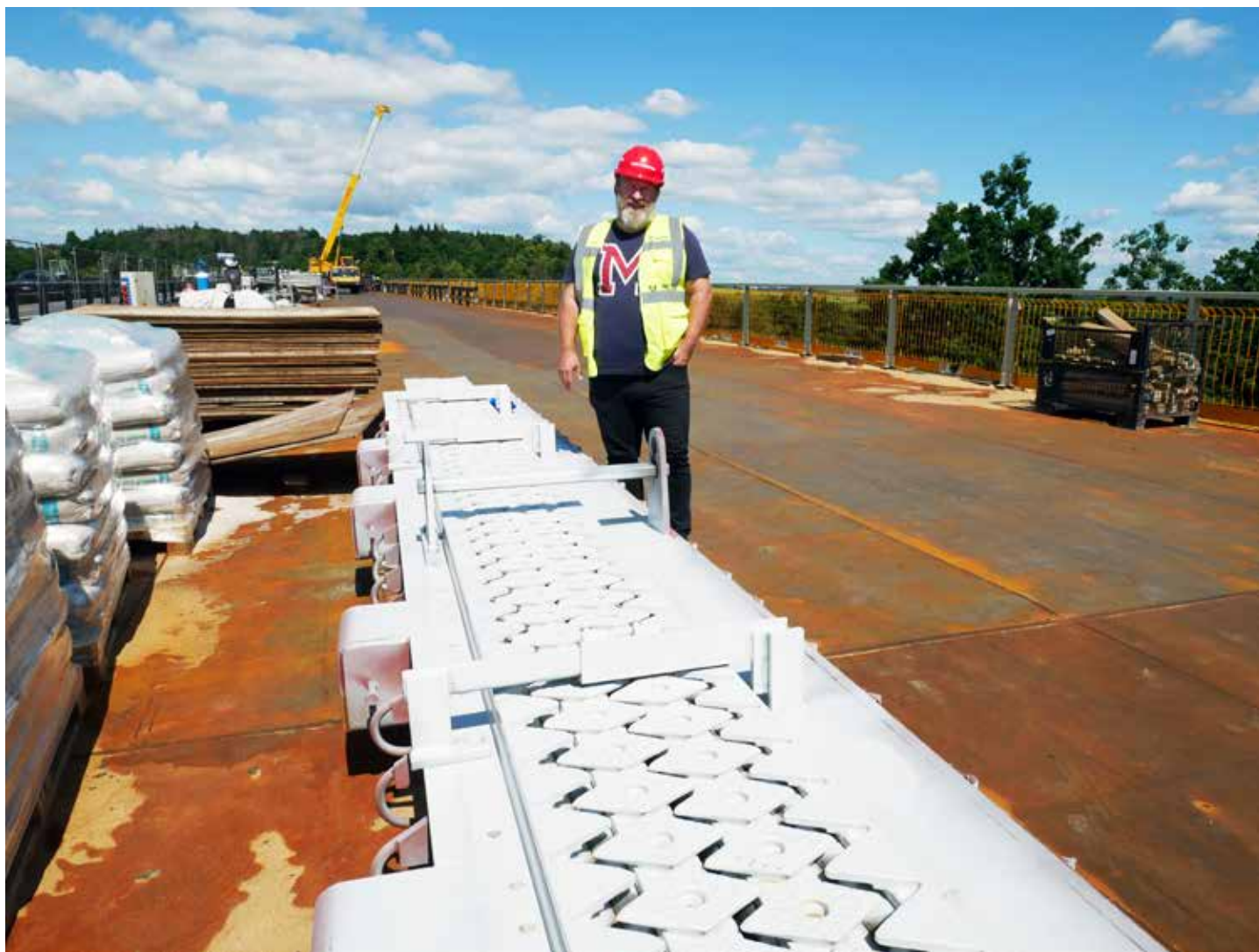
Oblastní ředitel Metrostavu Jiří Salava stojící vedle závěr s tichou úpravou
