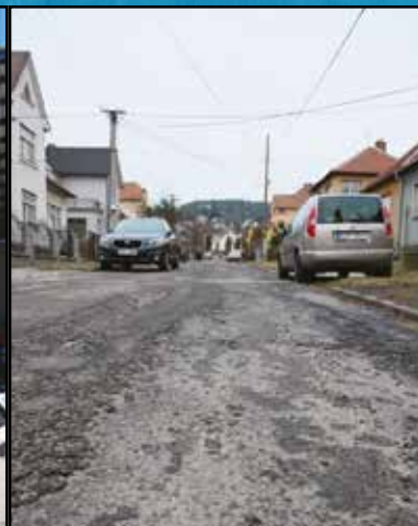
10) Rekonstrukce ulice ve Vilách
