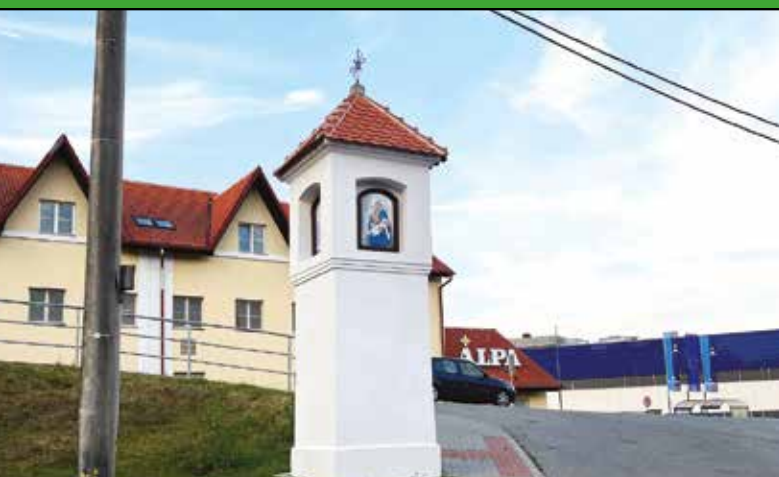
14) Oprava kapličky v ulici Uhřínovská
