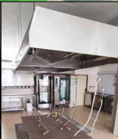
12) Oprava podlahy ve školní jídelně ZŠ Oslavická
