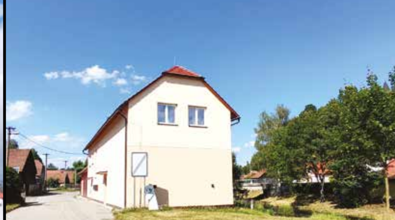
4) Obnova fasády na kulturním domě v Mostišťích
