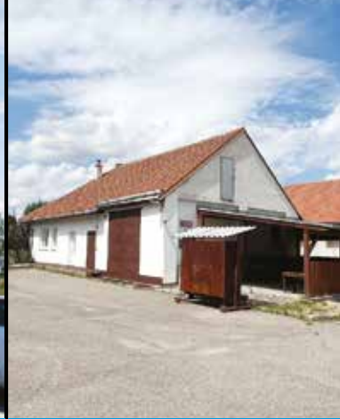
4) Nová vrata, Hasičská zbrojnice Hrbov
