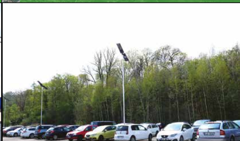
13) Instalace solárních svítidel na odstavňné ploše v bývalém areálu Svit
