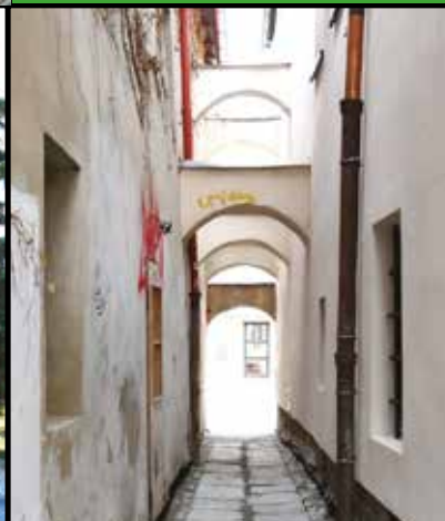
10) Oprava uličky V Podloubí
