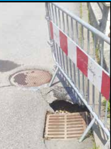
13) Oprava vpustí v ulicích VM
