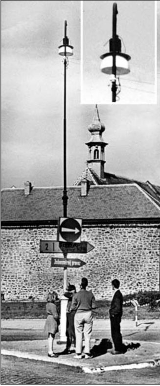
Křižovatka před Dolní branou, na starý stožár osazeno v roce 1961 první výbojkové světlo.
