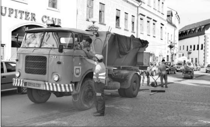
Během posledního červnového týdnu ještě před prázdninami pracovníci Technických služeb města Velké Meziříčí spravovali za provozu na náměstí výtluky ve vozovce. Text a foto: Martina Strnadová
