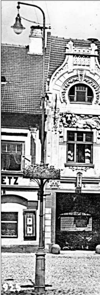
Elektrický sloup ve středu náměstí před hotelem Zlatý lev. Novodobý krásný stožár se žárovkovým svítidlem. Rok jeho instalace není znám. Foto: archiv VP
