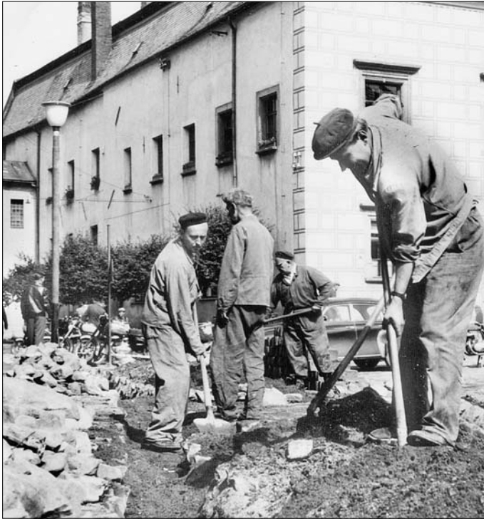
Náměstí 1956 – Zaměstnanci MNV provádějí zához výkopu pro kabel prvního žárovkového osvětlení.
