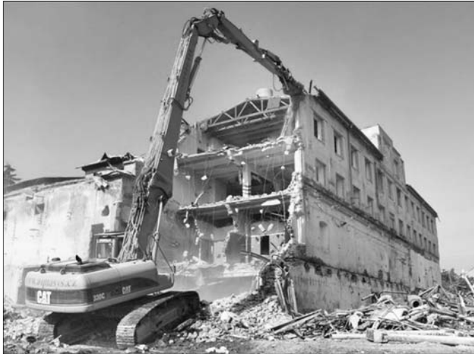
Budovy neodolaly náporu bagrů... Stav na snímku už je ale minulostí.
