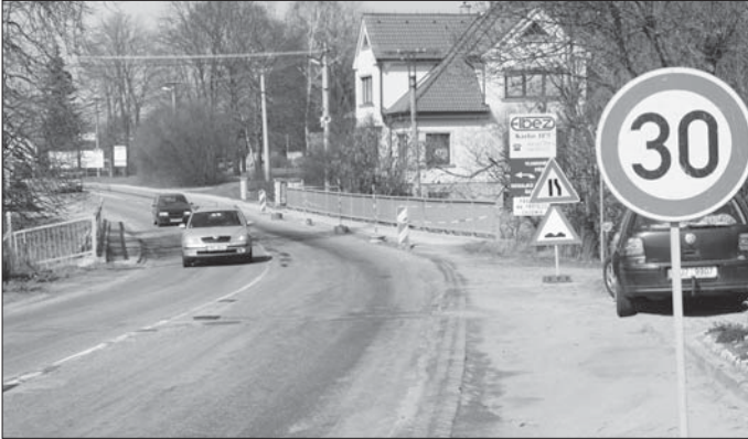
Most na Karlově by měl kraj Vysočina opravit ještě letos.
