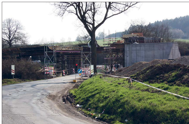
Výstavba mostu přes železniční trať a silnici II/360 je důvodem úplného zavření zmíněné vozovky – na snímku. Úsek se musí objíždět.
