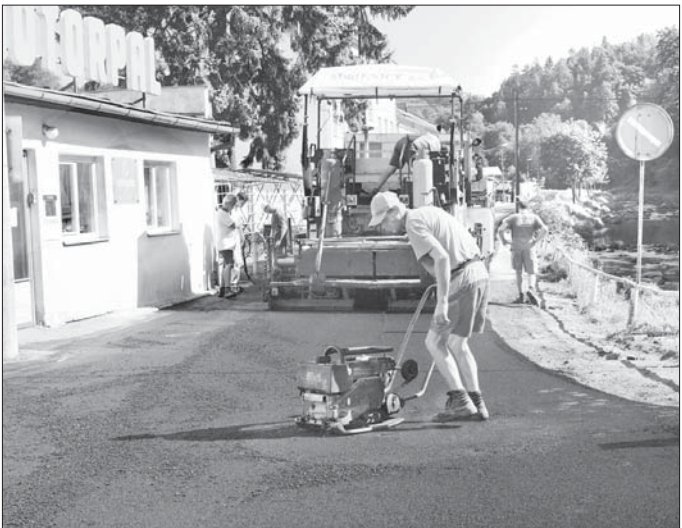
Novým úsekem cyklostezky kolem areálu bývalého Motorpalu lze již projet. V minulém týdnu byl dokončen asfaltový povrch. Foto: -vla-
