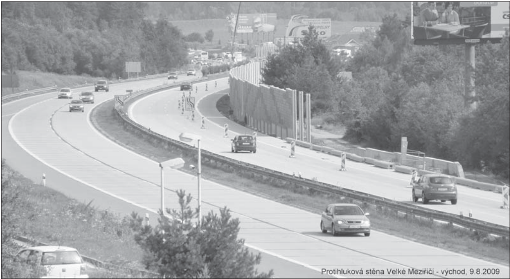
Snímek zachycuje výstavbu protihlukové stěny Velké Meziříčí Východ ze dne 9. 8. 2009.
