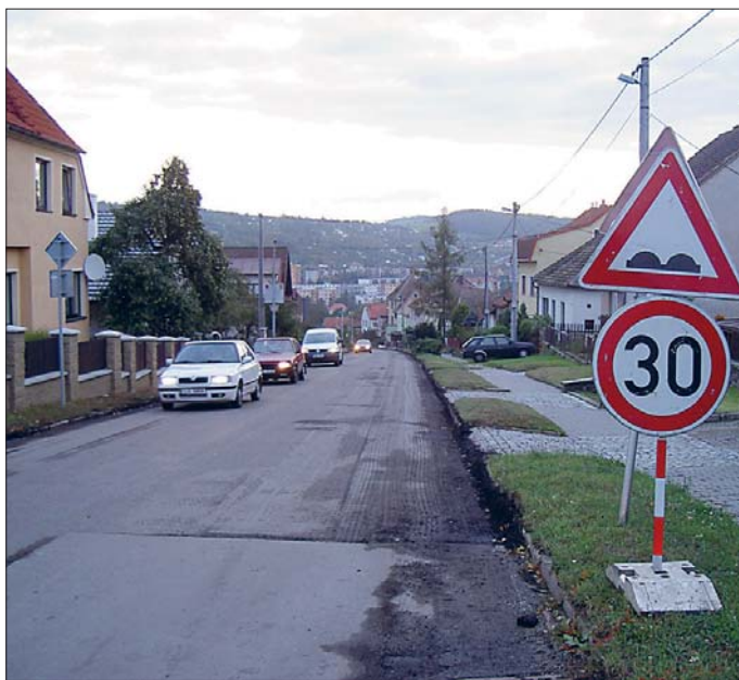
Snímek, na němž je vidět vyfrézovaná silnice, zachycuje stav na Třebíčské ulici v pátek ráno 2. října. Foto: Iva Horká
