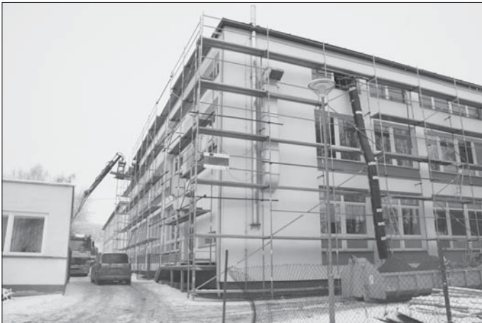
Práce na podkrovní vestavbě budovy základní školy v Měříně již probíhají. Foto: Martina Strnadová
