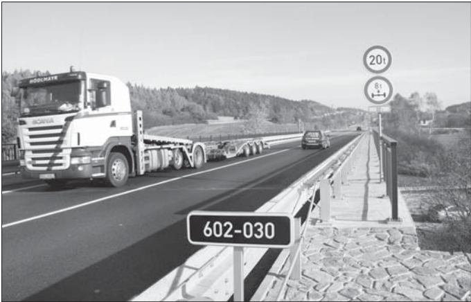
Po rekonstrukci je most nad dálničním exitem Velké Meziříčí západ. Foto: Martina Strnadová
