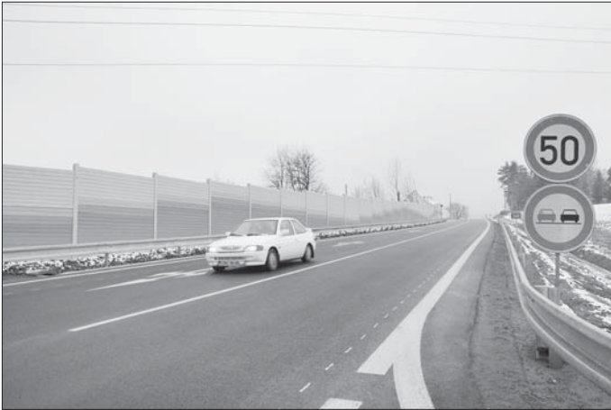
Řidiče potrápila nedávno objížďka do Třebíče kvůli stavbě přeložky silnice vedoucí kolem Oslavičky a rozcestí do Balin (na snímku). Za to si nyní mohou vychutnat jízdu po novém povrchu. Rychlost je v tomto prostoru omezena na 50 kilometrů v hodině.
