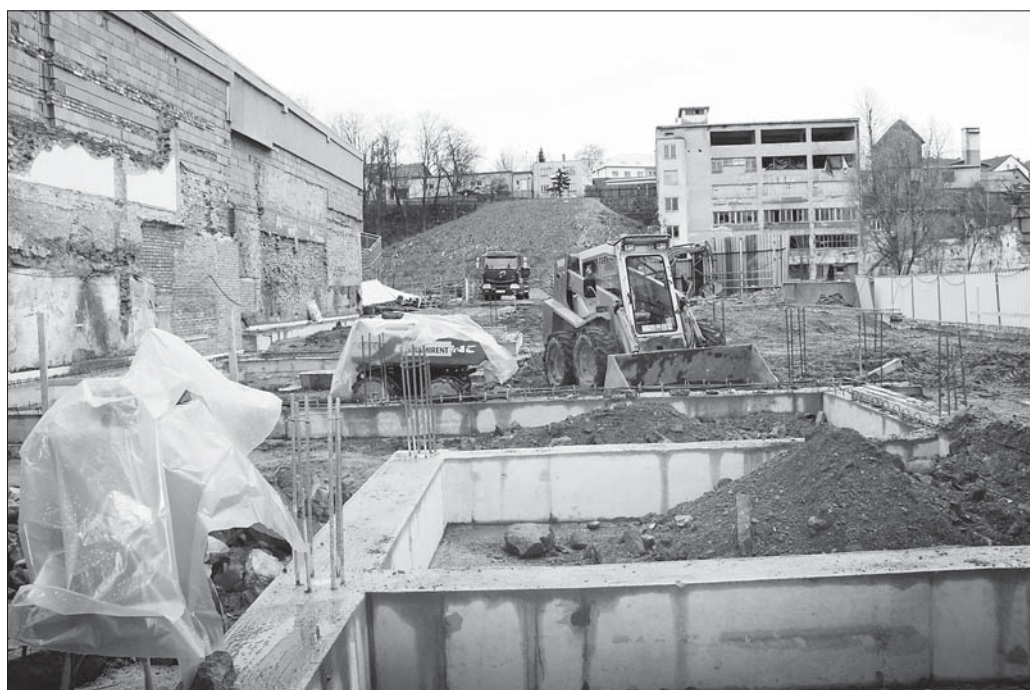
Nový Svit buduje investor z gruntu. V zadní části dvorního traktu již byly zbourány všechny staré objekty a v minulém týdnu byly založeny základy pro novou stavbu. Na jejich místě vyroste moderní dvoupodlažní obchodní pasáž propojená s hlavní budovou.
