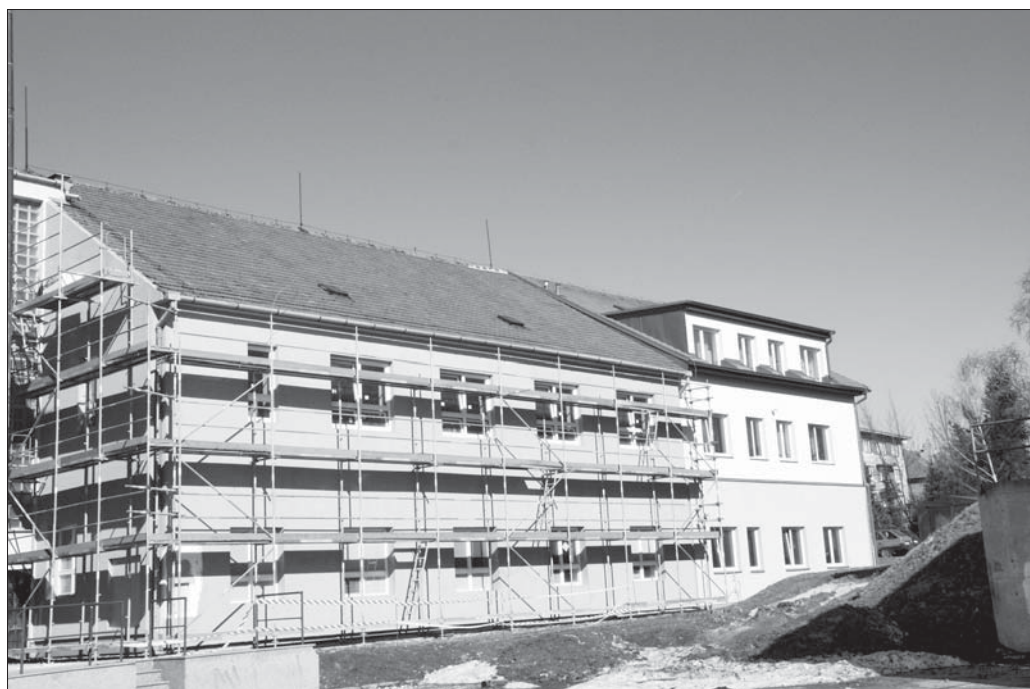
Budova bývalého katastrálního úřadu ve Velké Bíteši, v níž vzniká centrum obrábění pro střední odbornou školu Jana Tiraye, má již zateplený plášť a vyměněná okna i dveře. Uvnitř jsou dokončovány omítky, obklady i podlahy. Dílo by mělo být hotovo do konce června 2010.
