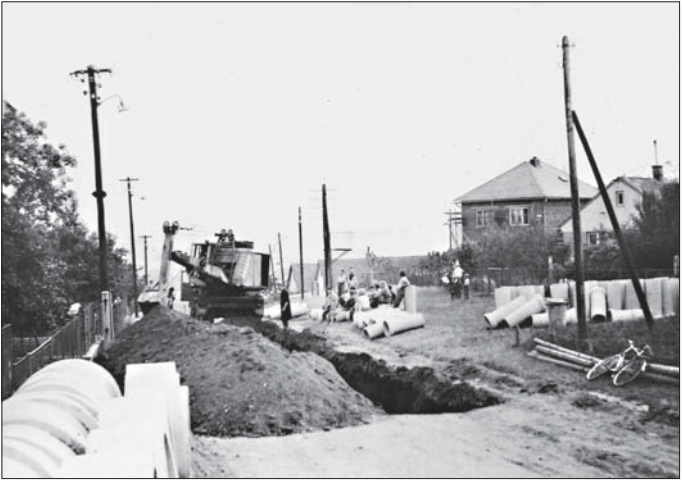
Rok 1969: Stavba kanalizace v ulici Na Spravedlnosti.
