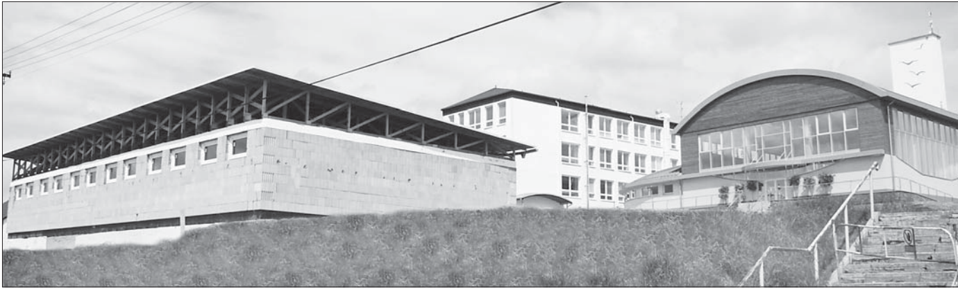
Celkový pohled na areál – vpravo nové centrum sportu a kultury, uprostřed základní škola a zcela vlevo rozestavěné zázemí pro centrum, kde budou sklady. K tomu přibude i parkoviště a venkovní hřiště. Foto: Iva Horká
