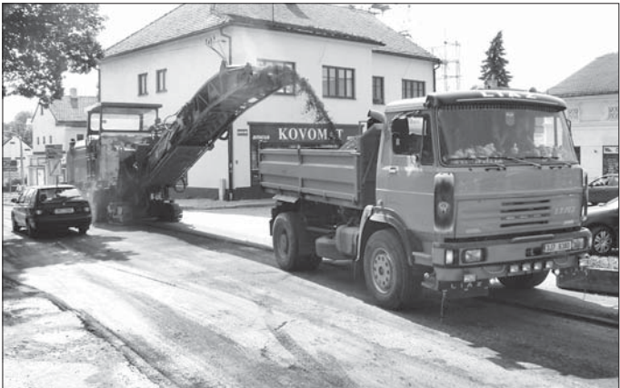
Frézováním vozovky ve východní části města 1. července byly zahájeny práce na opravě východní části náměstí. Foto: Miroslav Báňa
