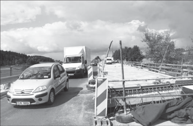
Provoz na Jihlavu brzdí už jen oprava jednoho mostu – nad dálničním exitem. Foto: Martina Strnadová
