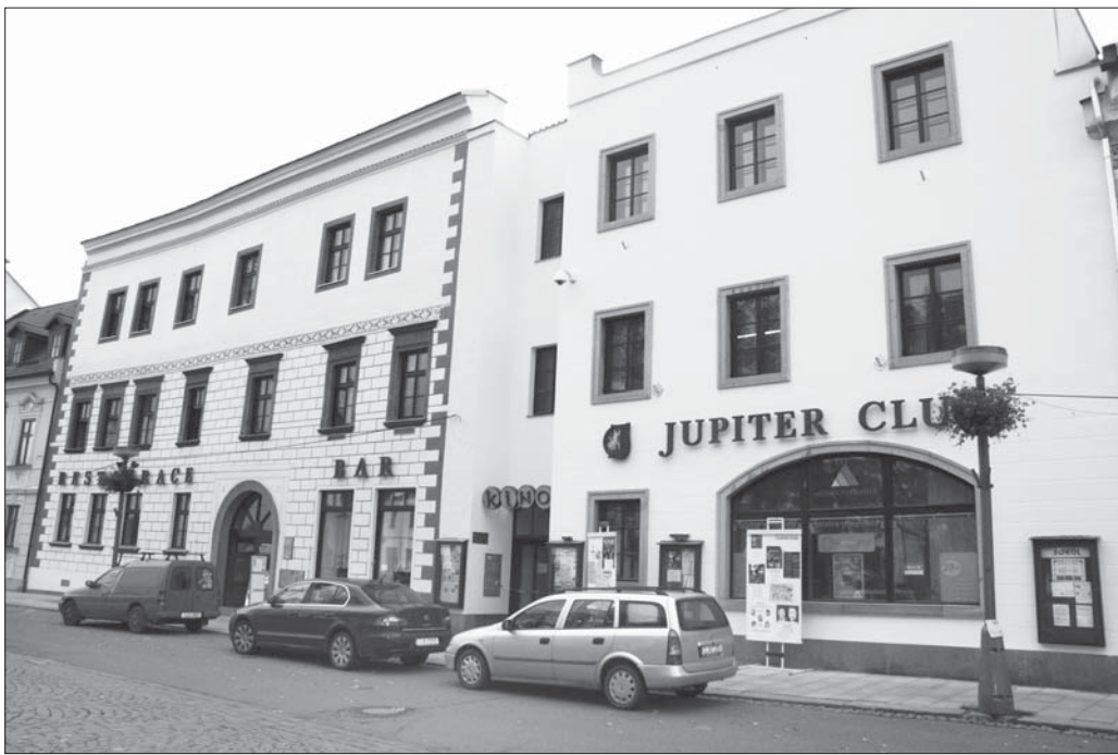
Necelé dva měsíce trvala oprava fasády Jupiter clubu. Současně byla natřena okna i hlavní vchodové dveře. Foto: Iva Horká
