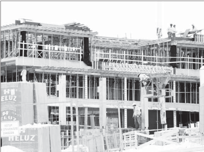
Pracovníci provádějí montáž prefabrikovaného skeletu.
