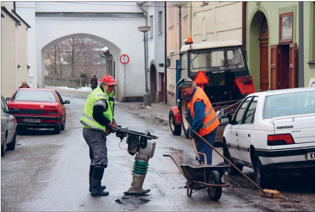
Pracovníci technických služeb minulý týden již začali asfaltovat výtluky na silnicích.
