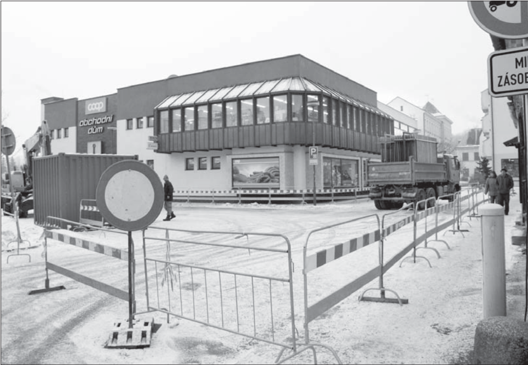
Parkoviště u Kotvy je od 3. ledna uzavřeno kvůli rekonstrukci kanalizace.
