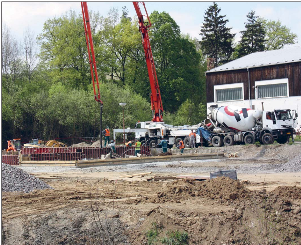
Práce na intenzifikaci čistírny odpadních vod v Nesměři jsou již v plném proudu. Foto: Martina Strnadová
