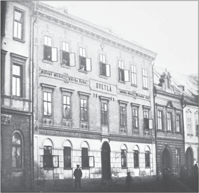
Původní budova školy Světlá na Náměstí ve Velkém Meziříčí (nyní budova České spořitelny).
