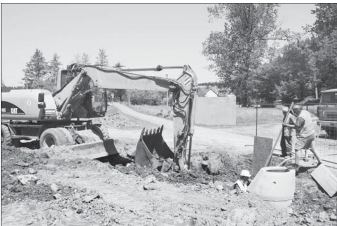
V Mostištích probíhají výkopové práce při výstavbě kanalizace vedle cyklostezky, ale i v dalších místech směrem k Vrchovecké ulici.
