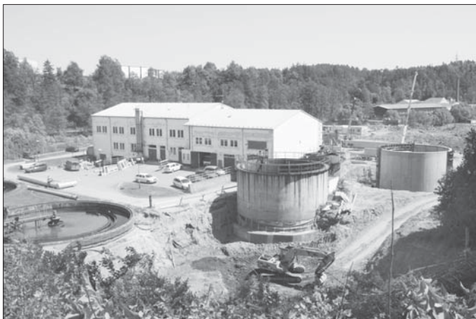
V rámci intenzifikace čistírny odpadních vod je nutno vybudovat objekty aktivace, dosazovací a uskladňovací nádrže a další.
