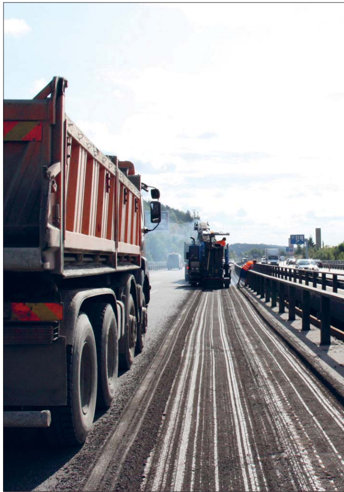
Práce odstartovaly toto pondělí a spočívaly v odfrézování horní vrstvy vozovky. Foto: Martina Strnadová
