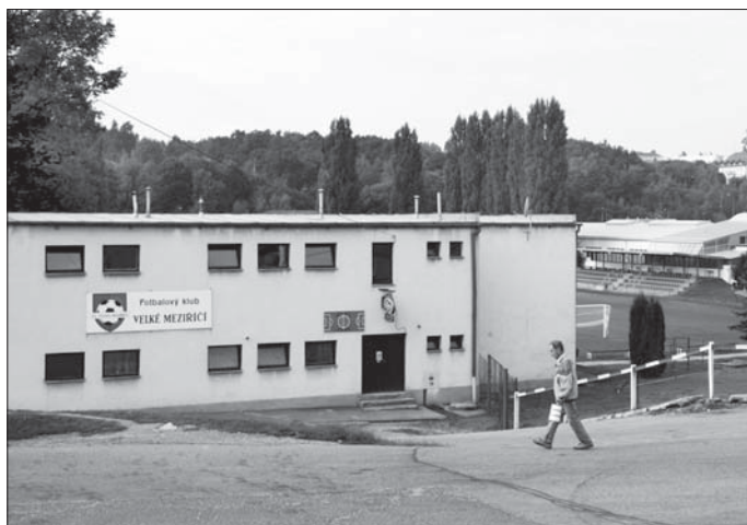
Výjma nové tribuny pro fanoušky (vpravo v pozadí) tvoří základy fotbalového klubu stará a nevyhovující budova v popředí, postavená ještě v „akci Z“. Foto: Martina Strnadová
