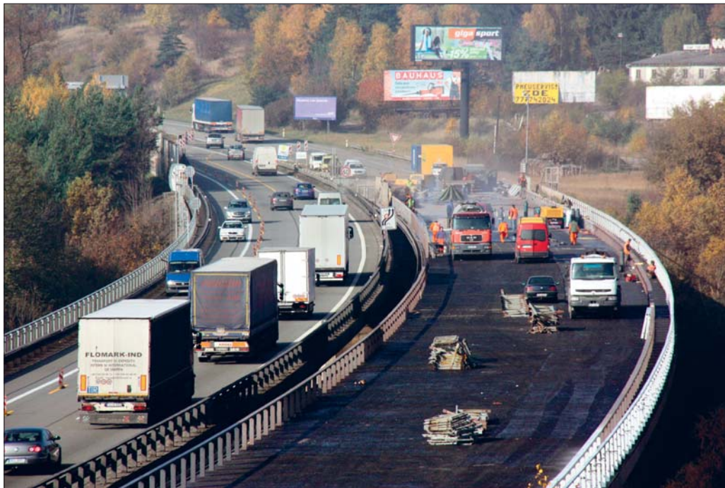
Práce na levé polovině dálničního mostu Vysočina se pomalu chýlí ke konci.
