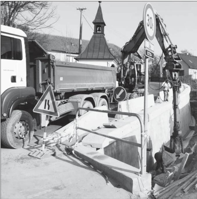
Silnice z Dolních Radslavic do Lhotek je již zprůjezdněna, ale práce ještě zcela neskončily.
