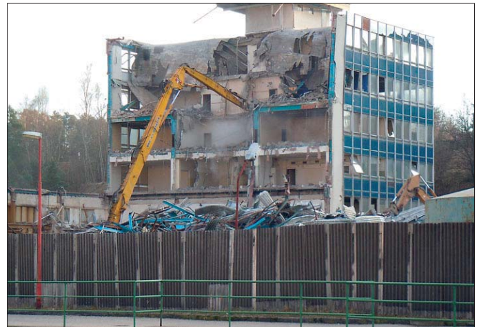
Ke zbourání je určena i vysoká modrá budova s někdejší nápisem Agromotor. Takto demolice pokračovala uplynulý víkend. Snímek byl pořízen v neděli 6. 2.
