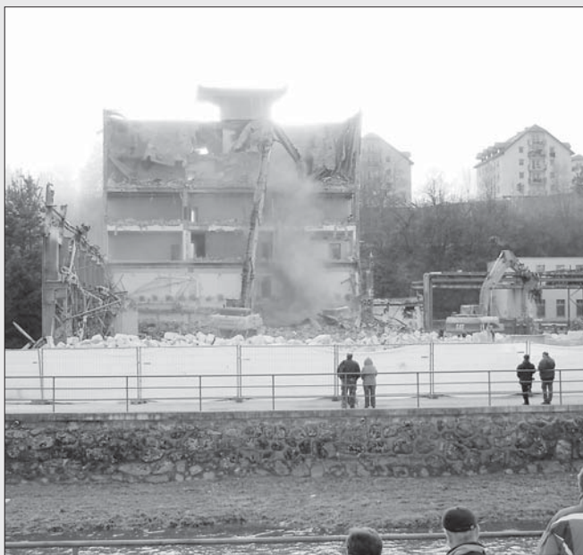
Budova Agromotoru zmizela. Snímky zachycují demolici budovy v areálu Agromotoru. Vlevo začátek bourání, vpravo aktuální stav z pondělí 14. 2. 2011.
