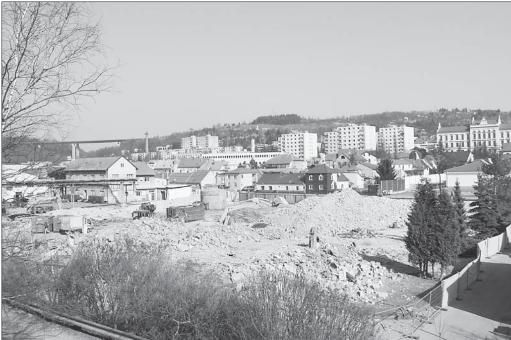
Demolice budov v areálu Agromotoru pokračuje.
