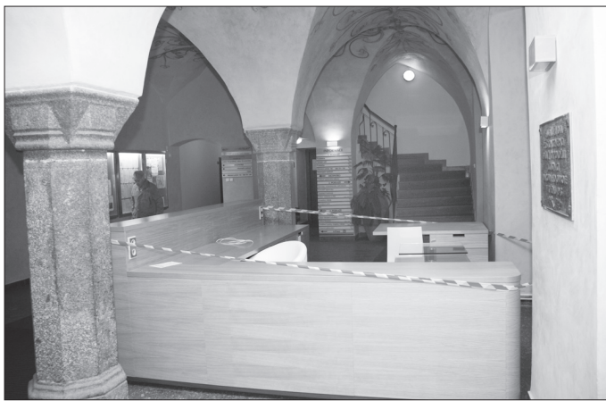
Základ recepcce je již připraven.
