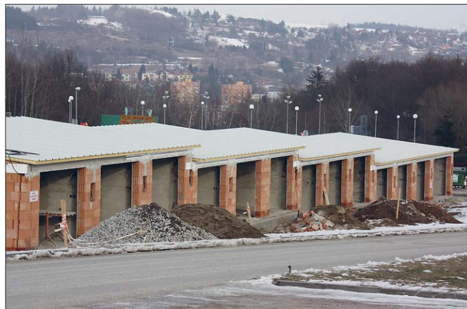
Nové garáže vyrůstají naproti základní škole. Jde o soukromou stavbu. Foto: Iva Horká
