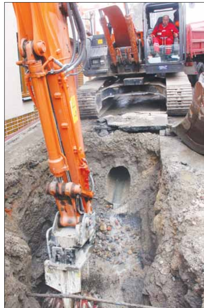
Práce při rekonstrukci kanalizace na Malé stránce ve Velkém Meziříčí jsou od minulého týdne v plném proudu. Foto: Martina Strnadová
