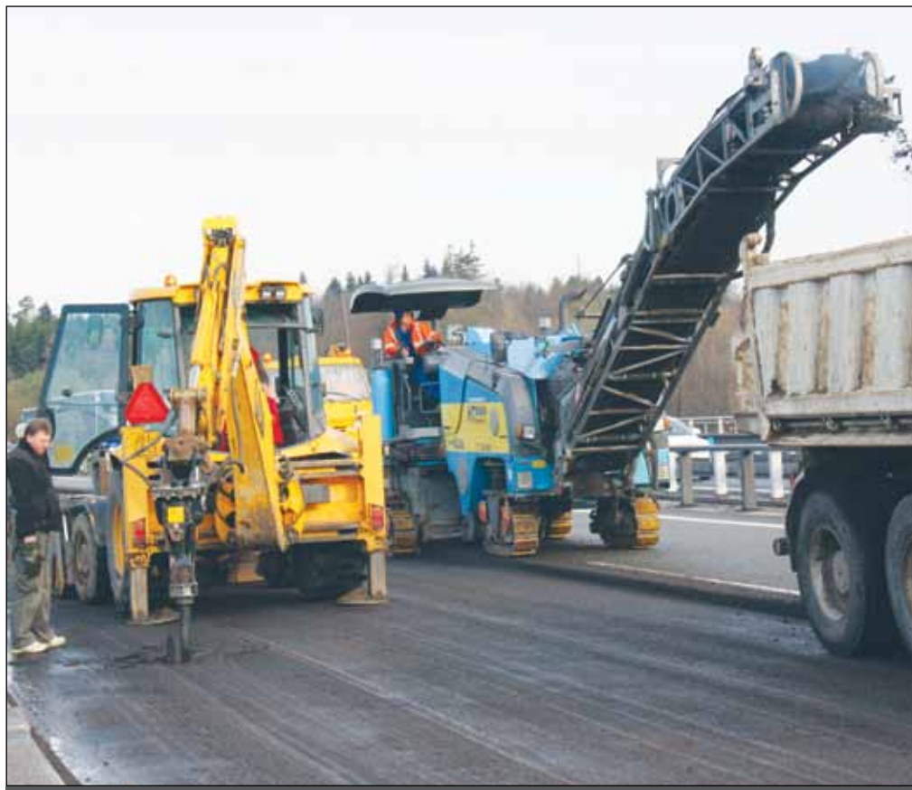
Rekonstrukce druhé půlky dálničního mostu - tedy té blíží k městu - začala minulou sobotu. Foto: Martina Strnadová
