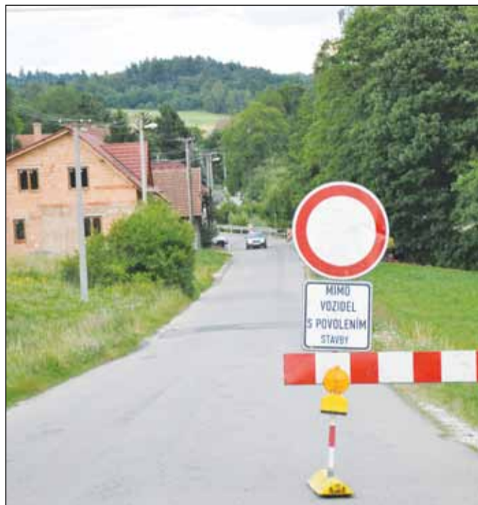
Úplná uzavírka Dolních Radslavic začala v pondělí. Foto: Martina Strnadová
